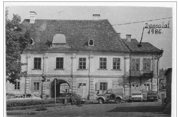
11. Vedere din anul 1969 , cu aspectul de atunci.
