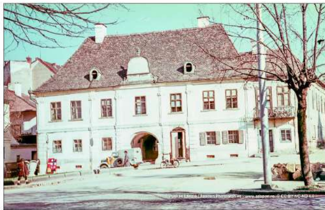
10. Vedere din anul 1969 , cu aspectul de atunci.
